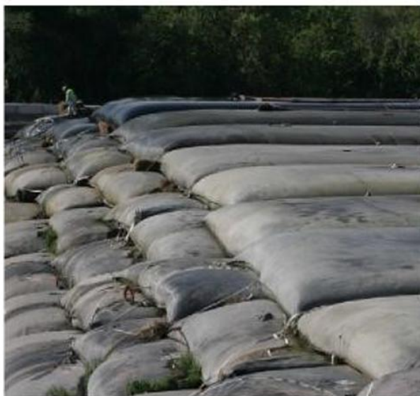
Slika 24: Piramidno zlaganje napolnjenih geotekstilnih cevi
