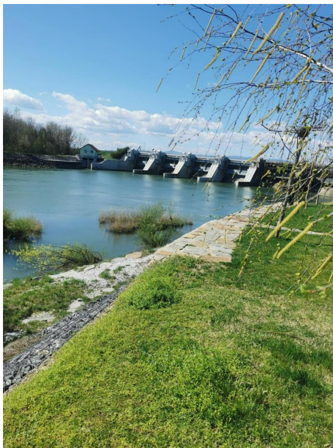
Slika 11: Jez Markovci z zapornicami
