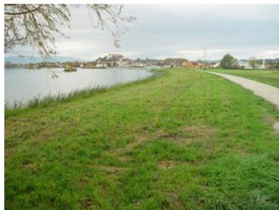
Slika 21: Prečrpavanje sedimenta na rob bazena in končna ureditev brežine
