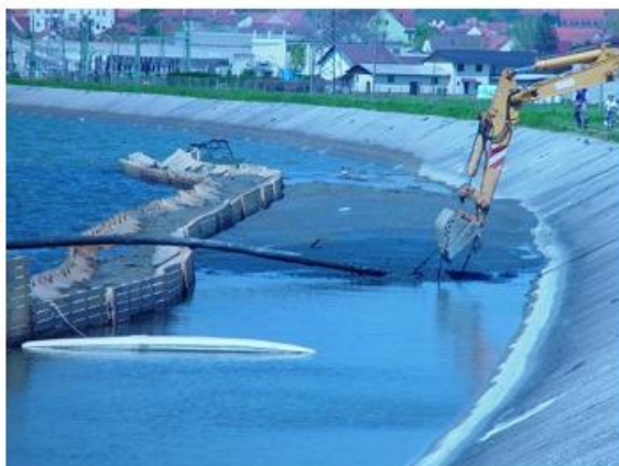
Slika 21: Prečrpavanje sedimenta na rob bazena in končna ureditev brežine
