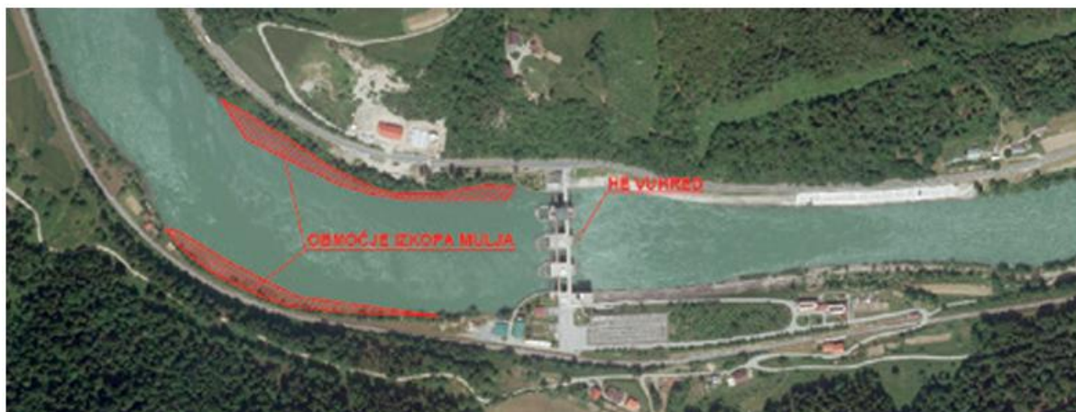
Slika 18: Pilotni projekt izkopa sedimenta pri HE Vuhred
