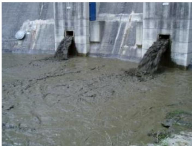
Slika 13: Občasno splakovanje sedimentiranega dna v dolvodni del reke, HE Langmannsperre
