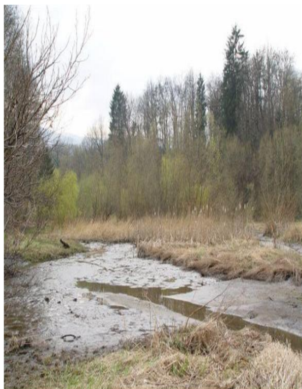
Slika 9: Usedline v koristnem metru akumulacijskega bazena in poraslost s trstiko HE Mariborski otok
