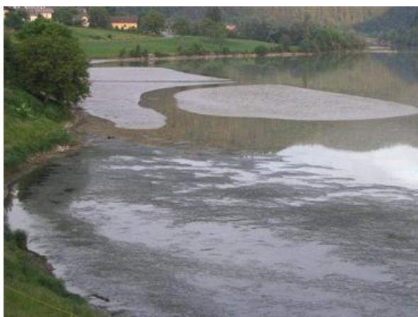
Slika 6: Usedline v koristnem metru akumulacijskega bazena in poraslost s trstiko v bazenu HE Vuhred
