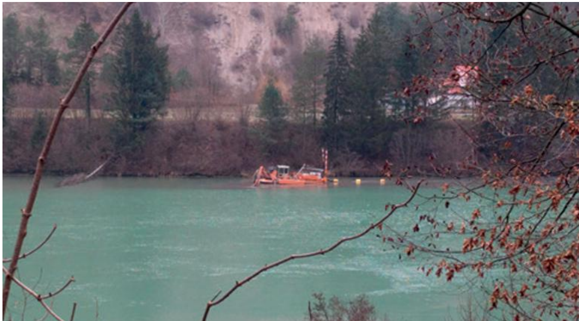
Slika 17: Izvajanje izkopa sedimentirane snovi ob bregovih akumulacije HE Vuhred s plavajočim bagrom
