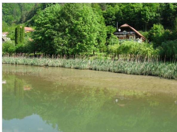
Slika 7: Usedline v koristnem metru akumulacijskega bazena in poraslost s trstiko v bazenu HE Ožbalt
