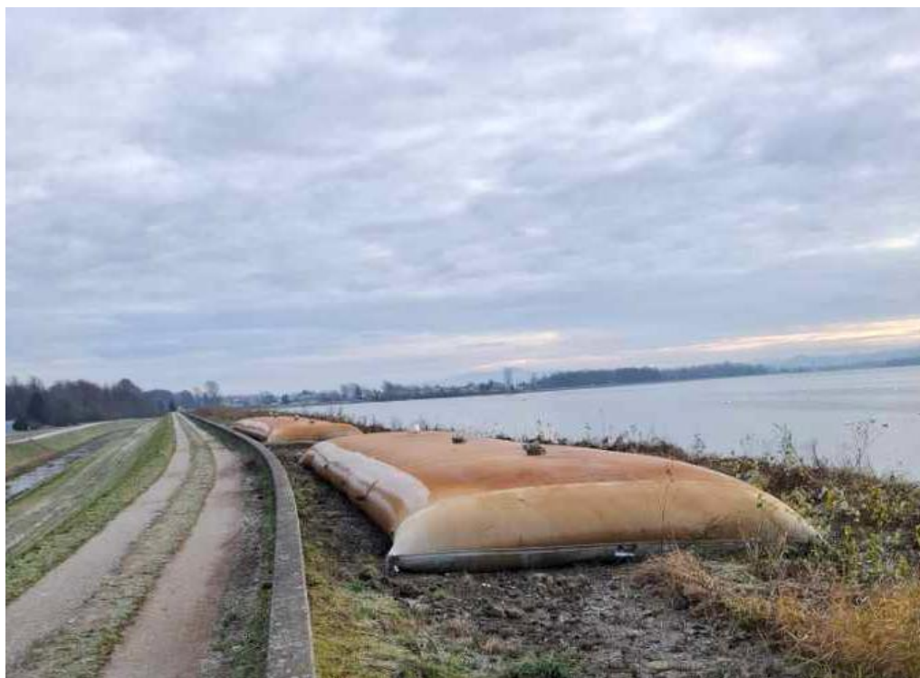
Slika 33: Sistem zlaganja geotekstilnih cevi na Ptujskem jezeru
