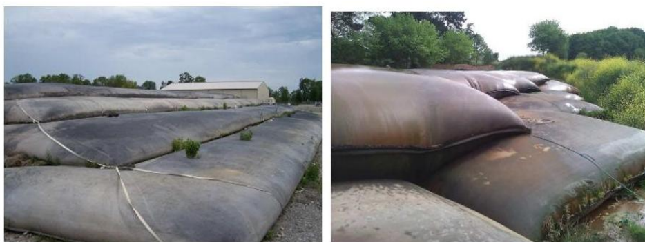
Slika 26: Prikaz večplastnega zlaganja in deformacij geotekstilnih cevi
