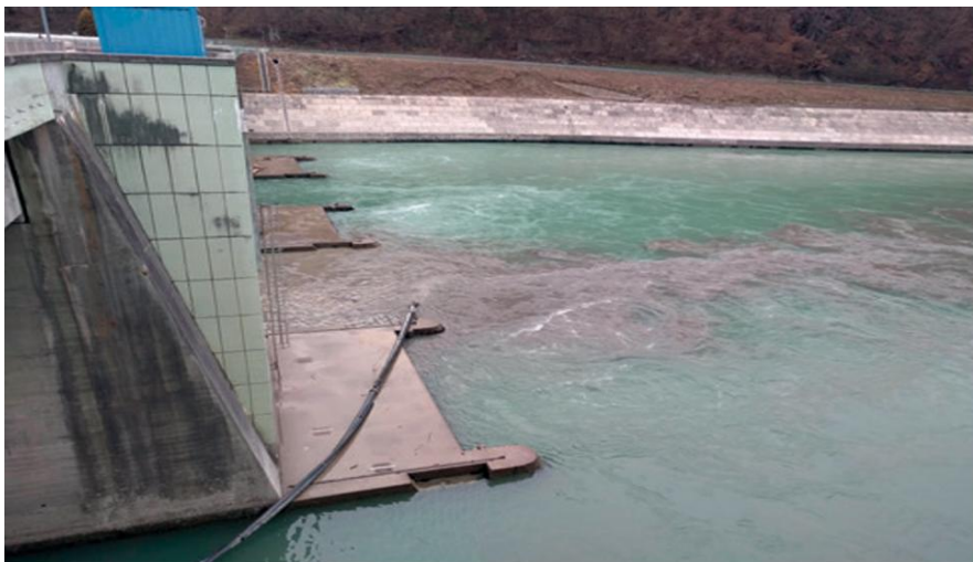
Slika 15: Iztok mešanice vode in usedline neposredno v spodnjo vodo HE Vuhred
