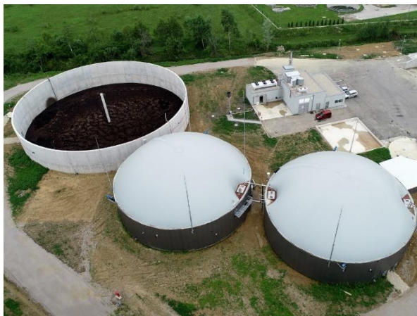
Slika 10: Bioplinsko postrojenje ( https://www.enerkon.hr/postrojenje-na-bioplin-pisarovina-1200-kwel/ )
