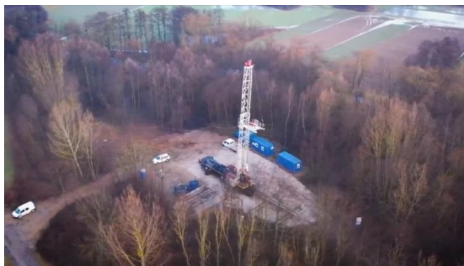
Slika 12: Izgradnja geotermalne elektrarne v Lendavi ( https://www.24ur.com/novice/slovenija/v-lendavi-bo-zrasla-prva-geotermicna-elektrarna.html )
