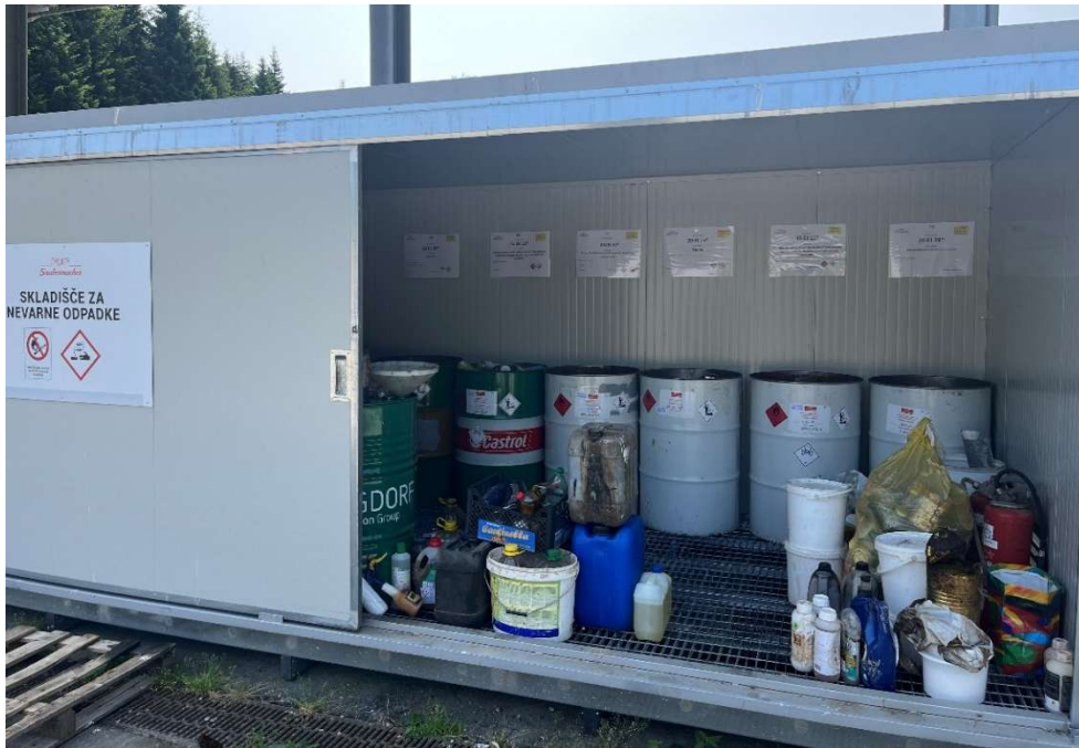
Slika 16: Skladišče za nevarne odpadke v Zbirnem centru Podhom (foto: N. Jug, 2025)
