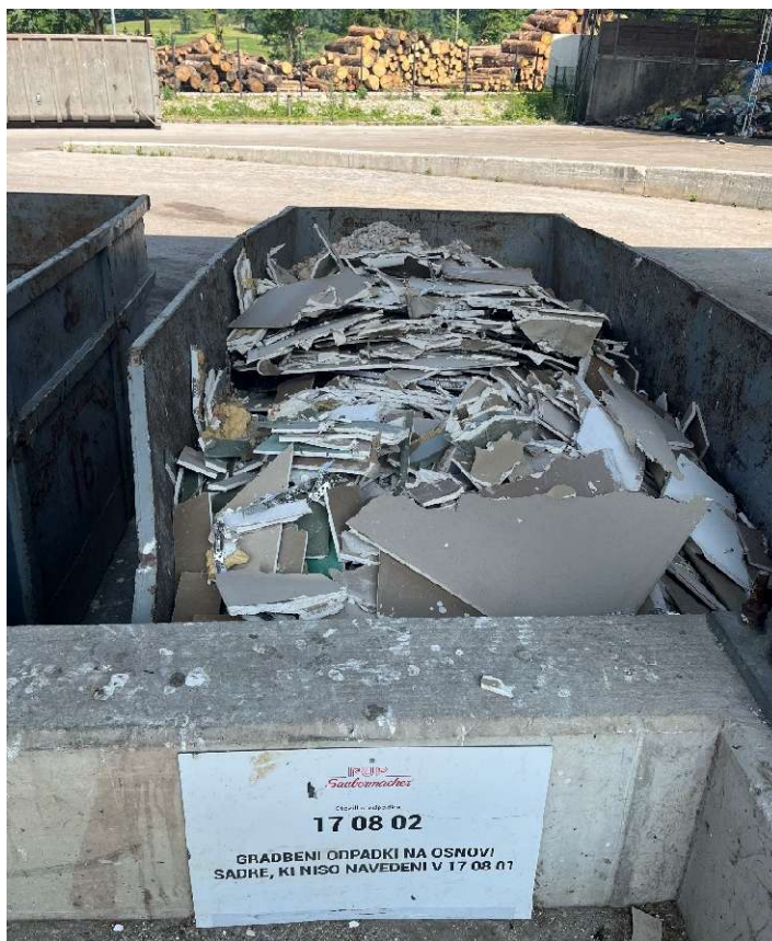
Slika 17: Gradbeni odpadki na osnovi sadre v Zbirnem centru Podhom (foto: N. Jug, 2025)
