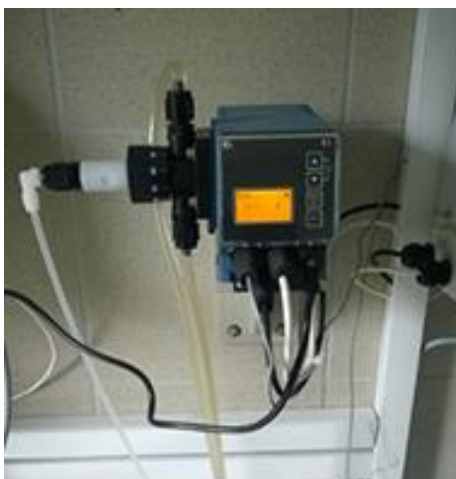
Slika 2: Naprava za dezinfekcijo pitne vode.
