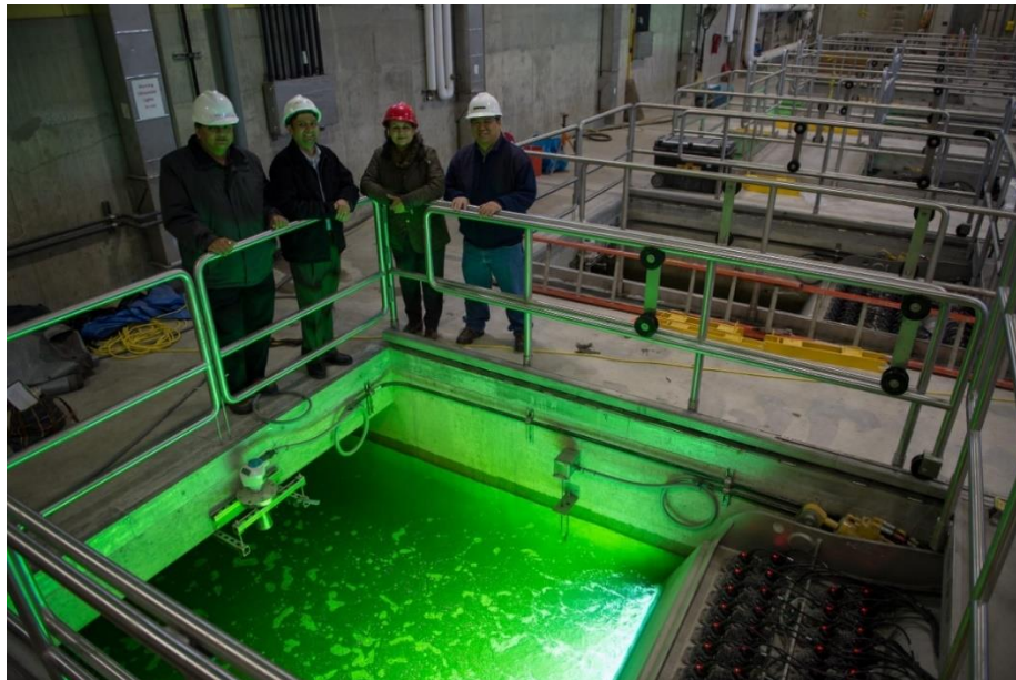
Slika 4: Obrat za UV dezinfekcijo.
