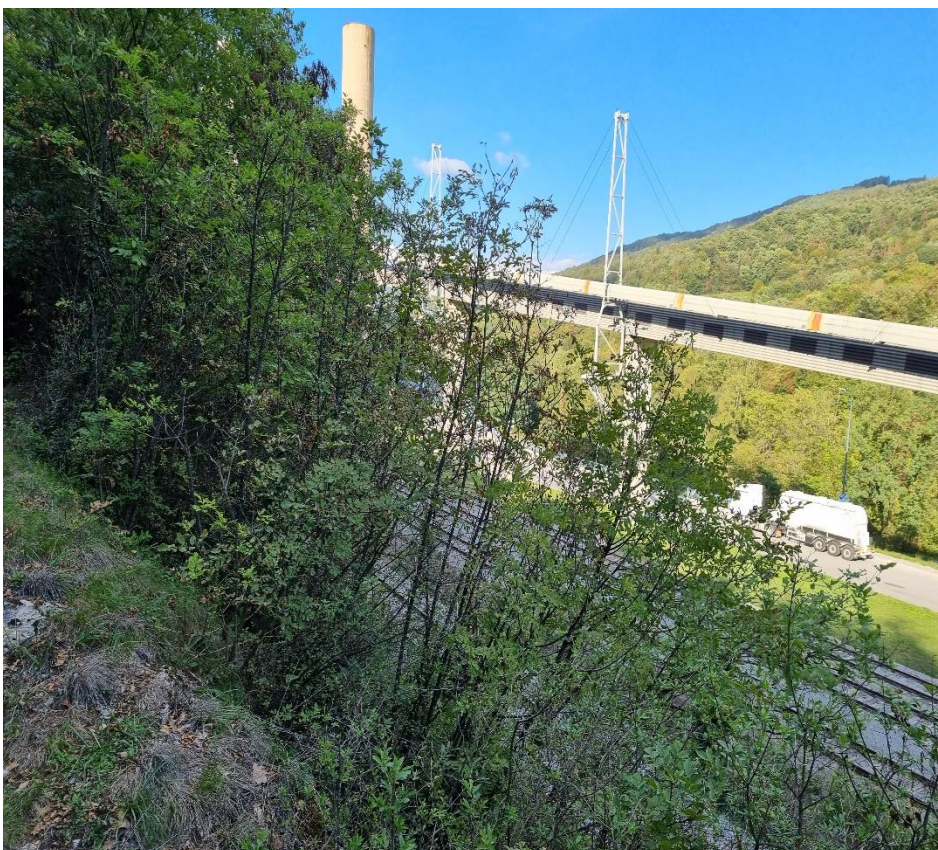
Slika 13: Pogled iz bližnjega gozda proti dimniku cementarne in dovozu cistern v cementarno (Vir: T. Vozelj, 2022)
