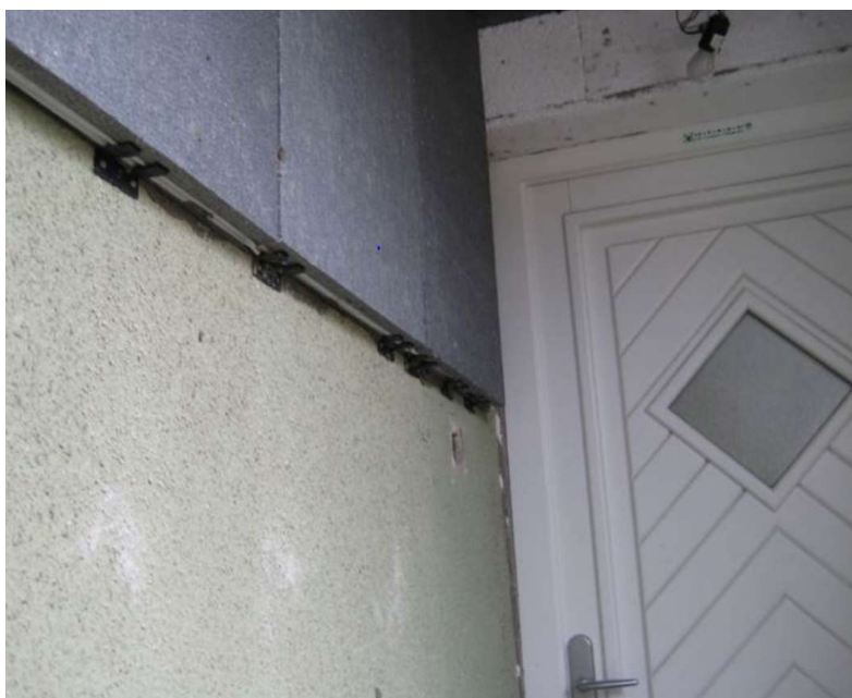
Slika 4: Umestitev VIP na starih objektih (vir: Turvac, 2013)
