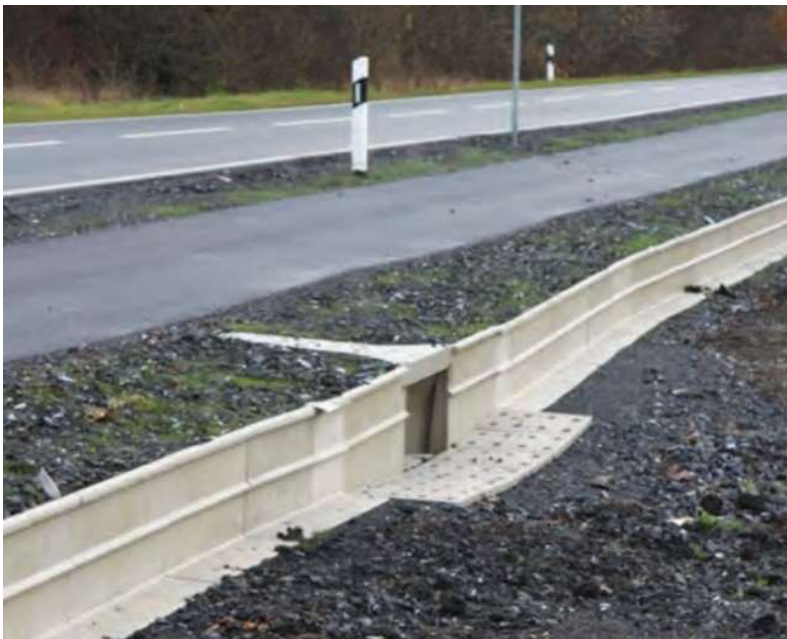
Slika 6: Škatlast prehod z varovalno ograjo za dvoživke (vir: prirejeno po Crowley in sod., 2016)
