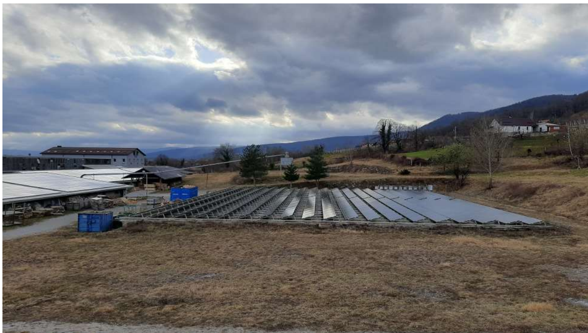
Slika 8: Skladišče odpadnega PCB (Vir: Val 202, 2020).
