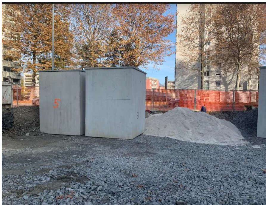
Slika 10: Betonska ohišja na gradbišču v starem delu Velenja (Vir: Klara Mirnik, 2021).
