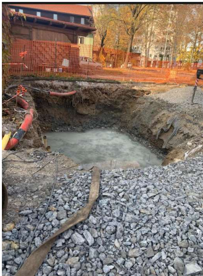
Slika 9: Gradnja podzemne zbiralnice v starem delu Velenja (Vir: Klara Mirnik, 2021).
