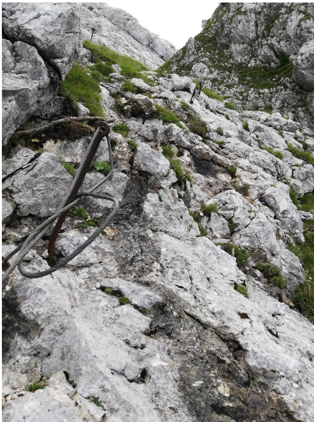
Slika 31: Pretrgana jeklenica na poti Čez Kajzlevo škrbino (foto: A. Prezel, 2019)
