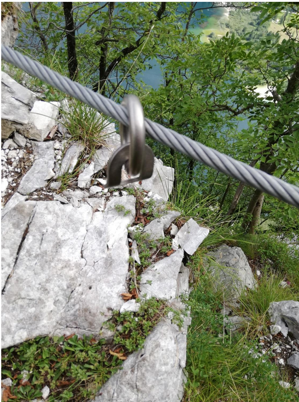
Slika 30: Nepritrjen svedrovec in obroč na poti Ožarjeni kamen (foto: A. Prezel, 2019)
