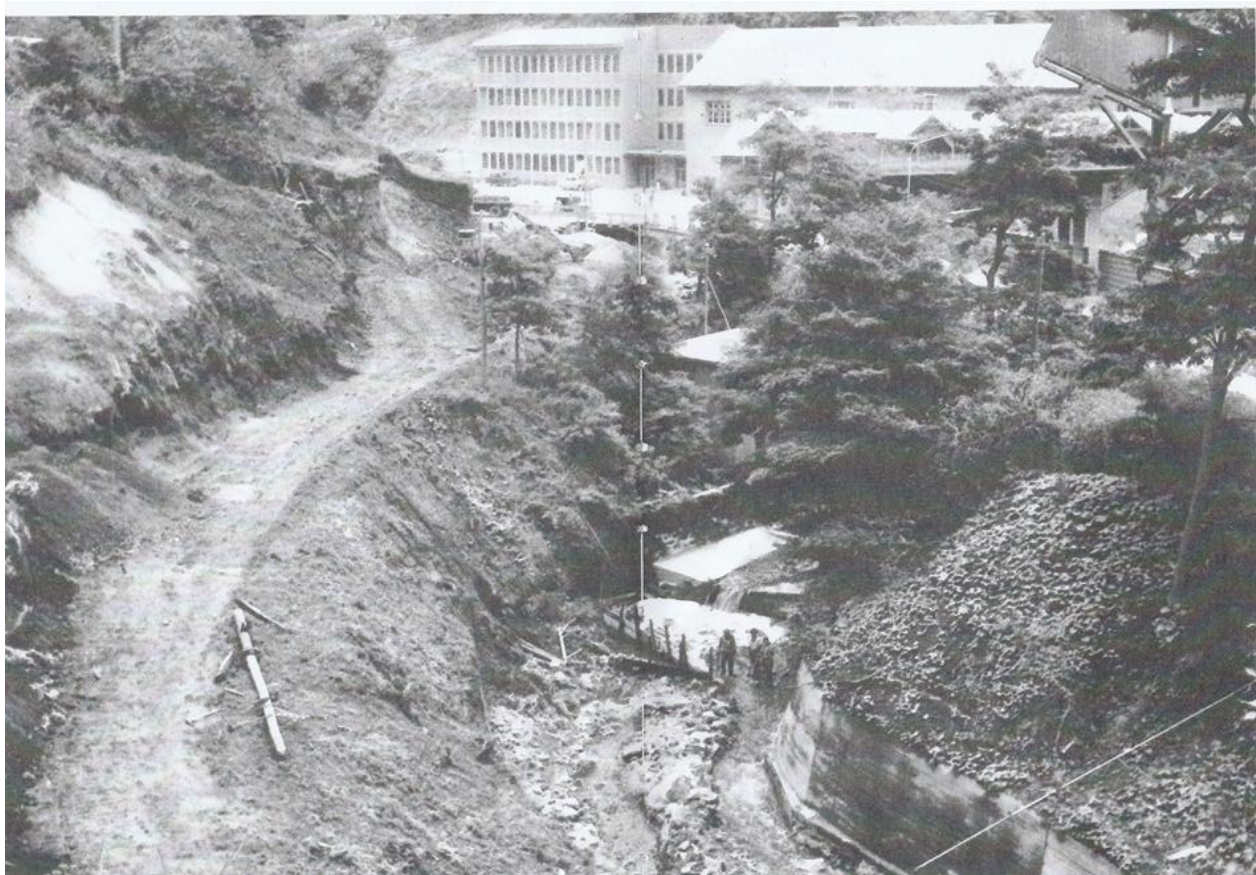
Slika 4: Nova regulacija potoka Trboveljščice in postavitev lokalne ceste Trbovlje Vir: Fritz Kunc, 2010, str. 104 - 105
