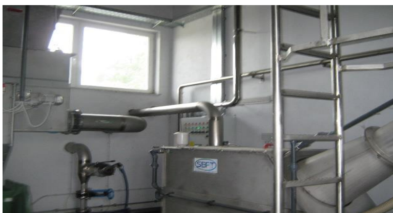
Slika 12: Naprava za sprejem blata iz greznic in MKČN (foto: Ž. Bezjak, 2018)
