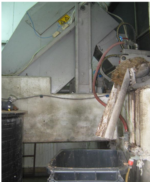
Slika 3: Stopničaste avtomatske grablje (foto: Ž. Bezjak, 2018)
