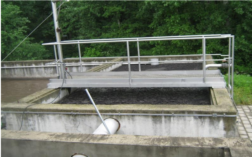
Slika 4: Imhoffov dvoetažni usedalnik (foto: Ž. Bezjak, 2018)
