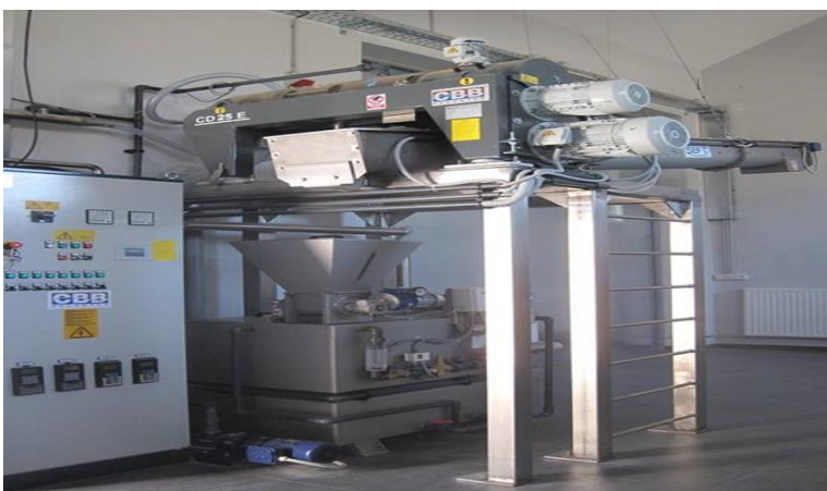
Slika 11: Centrifuga- dekanter s postajo za pripravo raztopine polielektrolita (foto: Ž. Bezjak, 2018)
