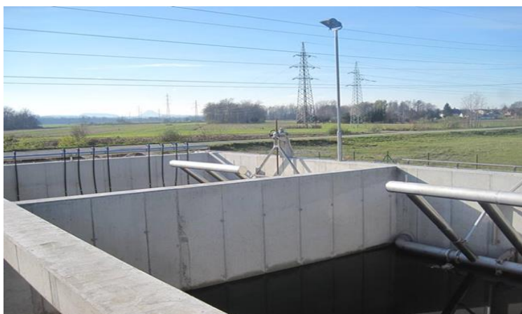
Slika 9: SBR bazena (foto: Ž. Bezjak, 2018)
