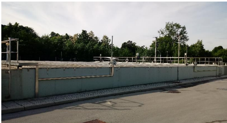
Slika 7: Kontaktni bazen, biološki reaktor – SBR 1 in SBR 2. (Foto: Jekovec, U., 2018)
