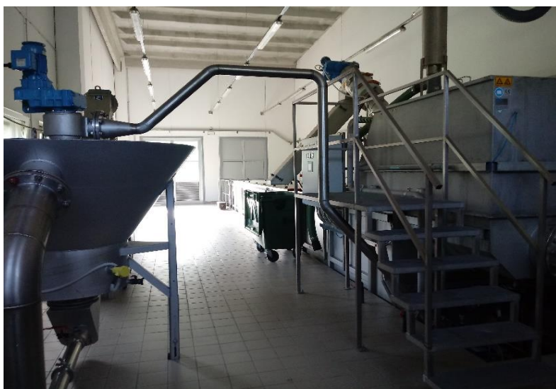
Slika 9: Grobe grablje in vhodno črpališče. (Foto: Jekovec, U., 2018)
