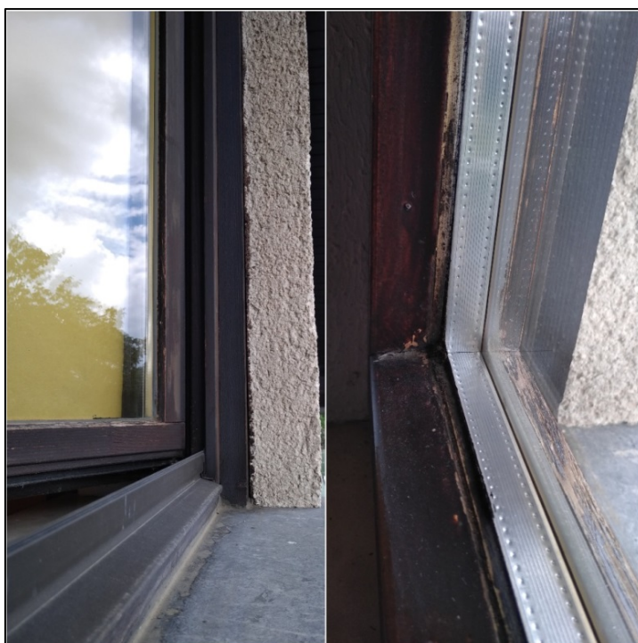
Fotografija 8: Dotrajana okna v mansardi (foto: T. Brenčič, 2018)
