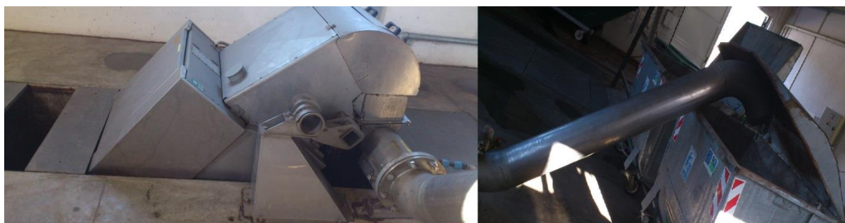
Slika 5: Fine grablje in odlaganje mehanskih delcev v kontejner
