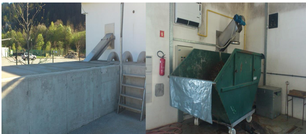
Slika 7: Peskolov s prezračenim maščobnikom in odlaganje maščob v kontejner Vir: Lasten, 2015
