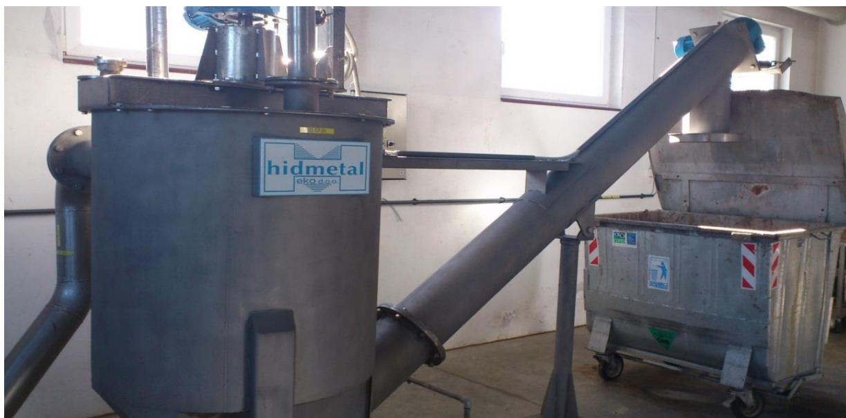
Slika 6: Pralnik peska z odlaganjem v kontejner Vir: Lasten, 2015
