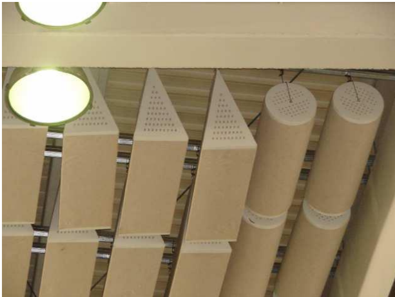
Slika 6.7: Namestitev stropnih absorberjev zvoka Vir: Tadić, 2014
