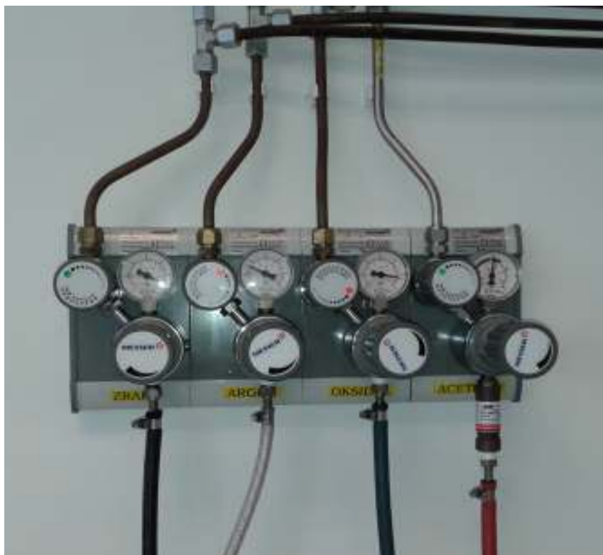
Slika 7: Plini, ki se najpogosteje uporabljajo pri plamenski AAS (zrak, didušikov oksid in acetilen); foto: J. Trbojević, 2015
