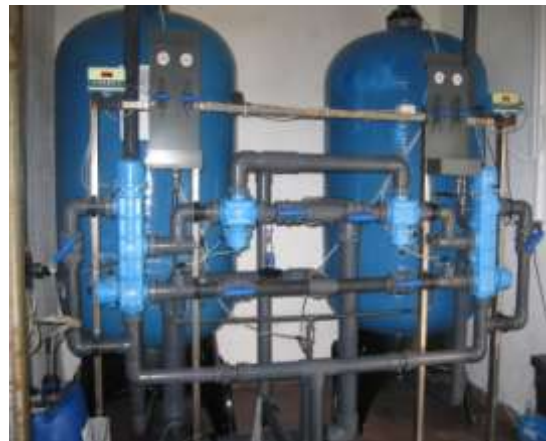
Slika 19: Hitri peščeni filtri Vir: Š. Maček, 2015
