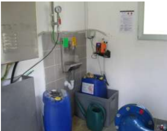
Slika 18: Naprava za doziranje klora Vir: Š. Maček, 2015
