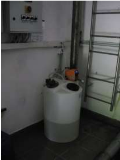
Slika 20: Naprava za doziranje koagulantov Vir: Š. Maček, 2015
