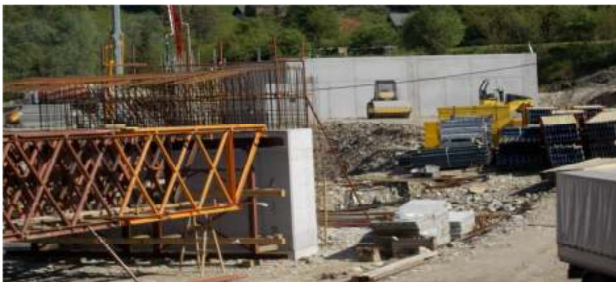
Slika 10: Izgradnja čistilne naprave na Dobrijah (Foto:A. Čurič, 6.5.2014).
