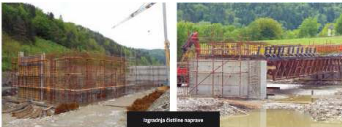
Slika 11: Izgradnja čistilne naprave na Dobrijah
