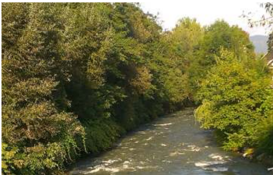
Slika 13: Neurejena struga Meže pod mostom za Leše na Prevaljah (Foto: A. Čurić, 8.9.2014)
