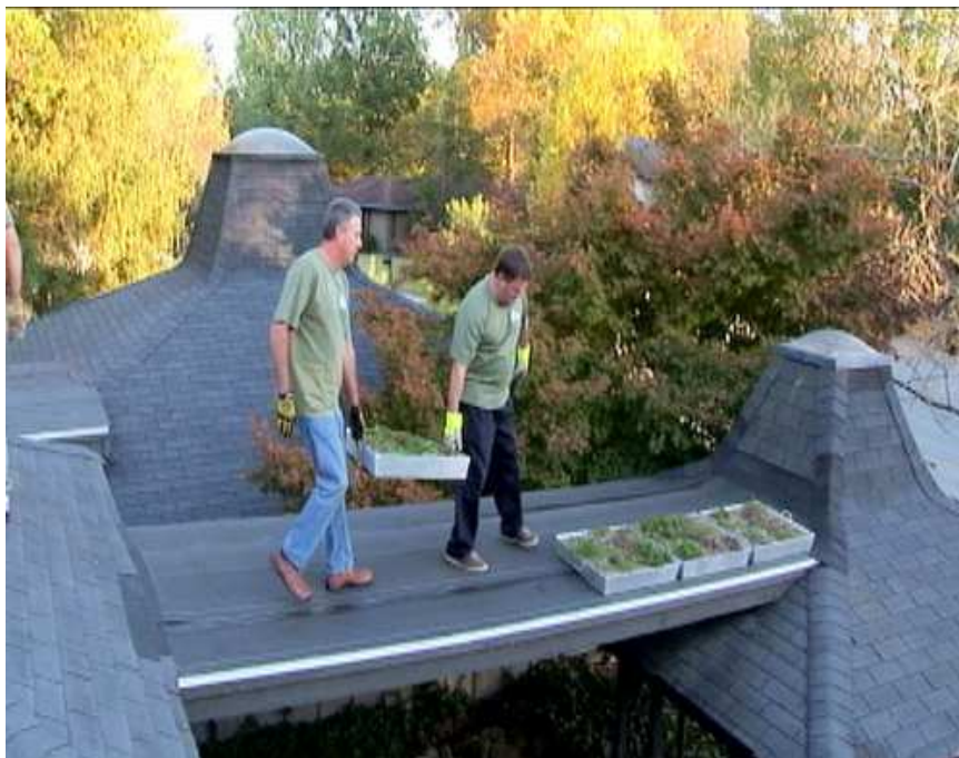
Slika 20: Enostavna postavitve sistema Green roof blocks (Vir: medmrežje 9)
