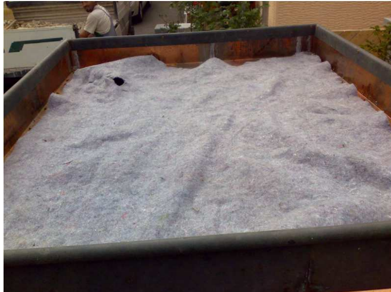
Slika 6: Filtrirni sloj (Vir: medmrežje 6)
