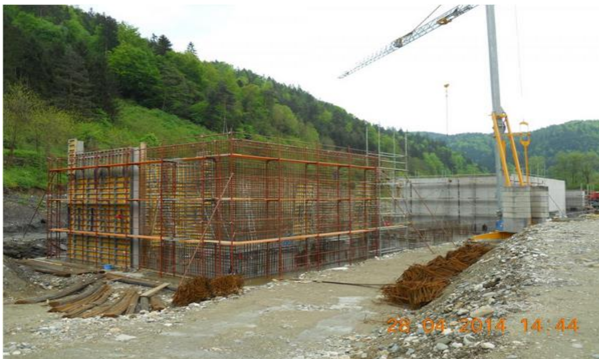
Slika 16: Čistilna naprava na Dobrijah v času gradnje (Vir: http://www.zacisteravne.si/novice/potek-gradnje-centralne-%C4%8Distilne-naprave-ravne# )
