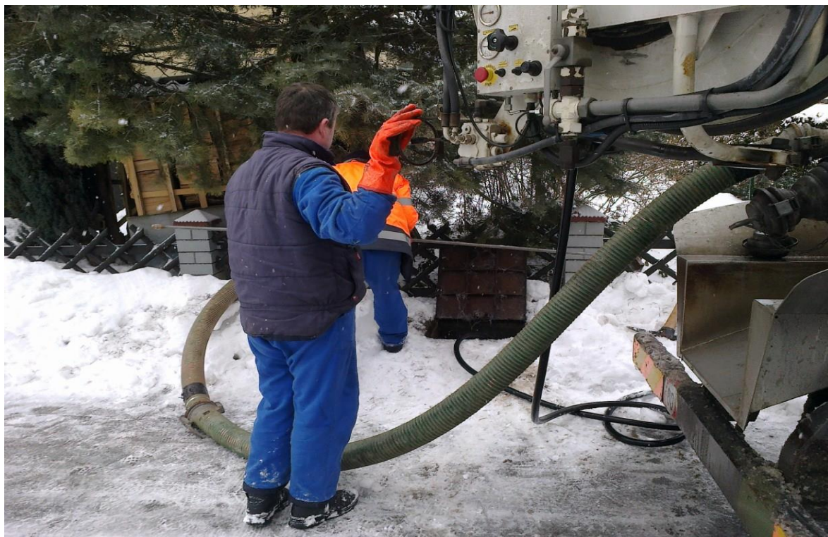
Slika 8: Črpanje greznične gošče iz stanovanjske hiše (Vir: lasten)
