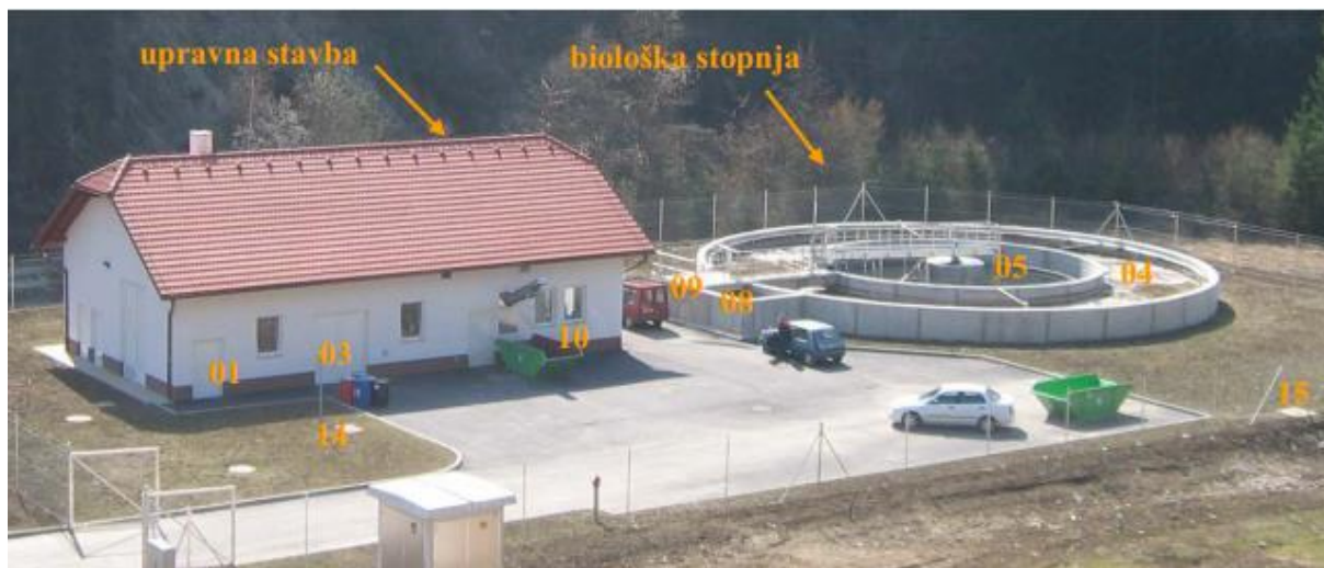
Slika 14: Čistilna naprava Mežica
