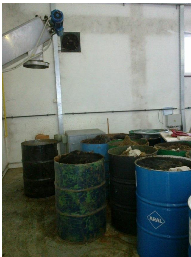
Slika 2: Zbiranje maščob iz odpadne vode na ČN Slovenj Gradec (Vir: lasten)
