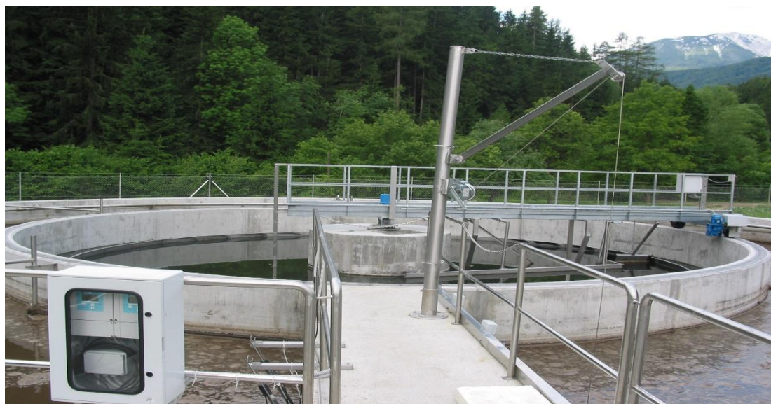
Slika 15: Čistilna naprava Mežica
