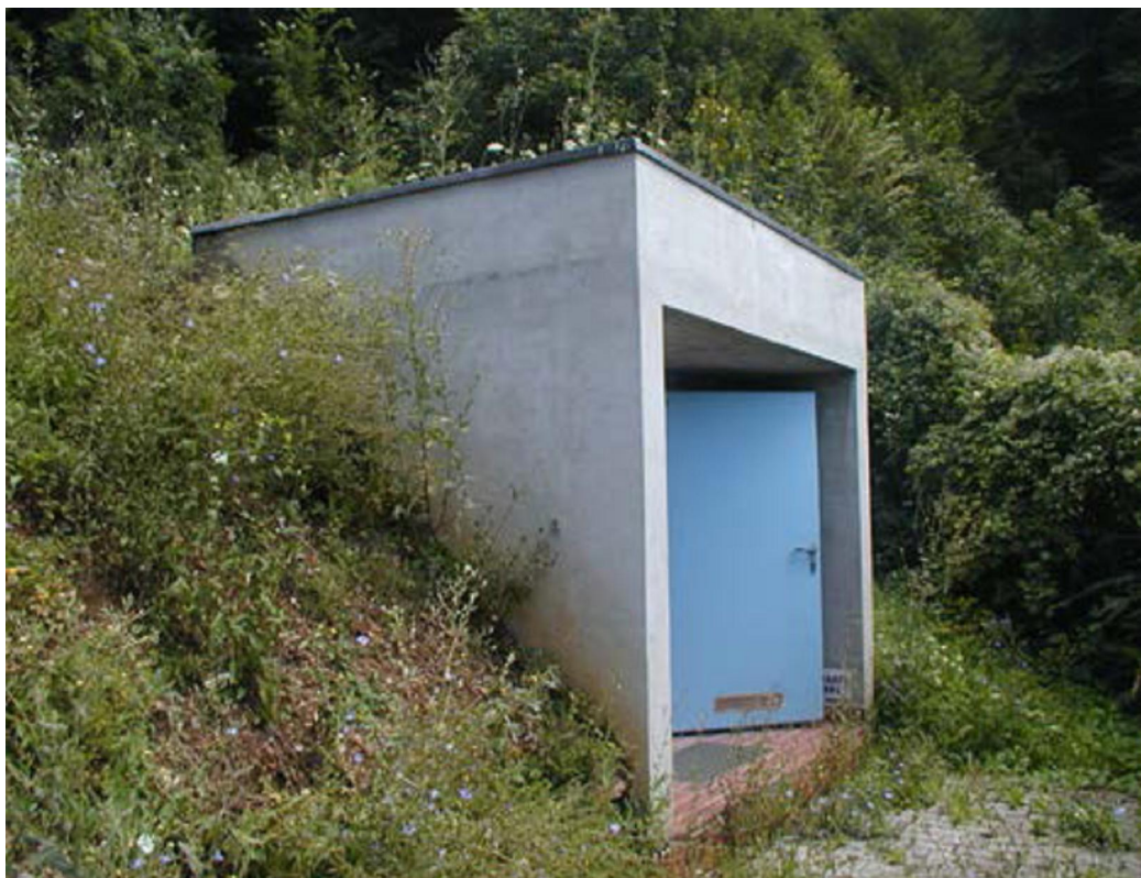
Slika 9: Vodohran Rečica (Vir: Stropnik, P. 2006. Hidravli na analiza vodovodnega sistema Šmartno ob Paki)
