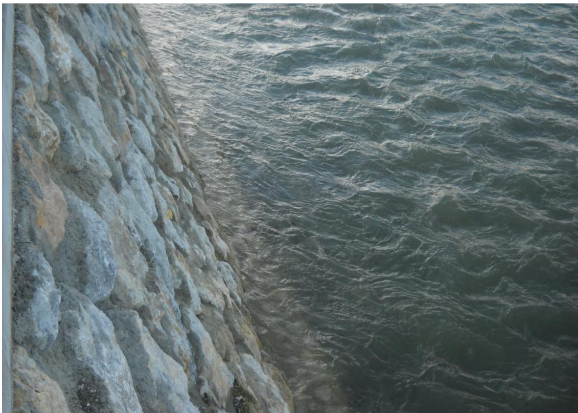
Slika 39: Ureditev desne brežin reke Savinje pod Petri kom (Vir: Bukovski, 2012).
