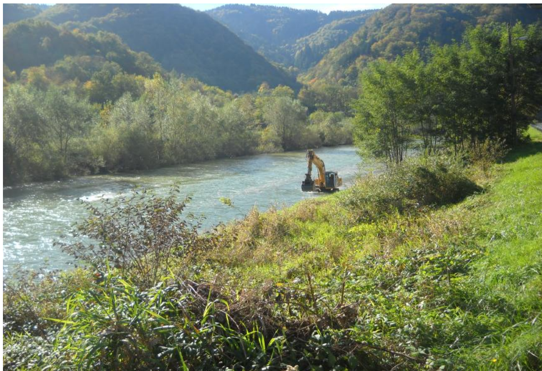
Slika 25: Gradnja protipoplavne zaš ite na obmo ju Polul (Celje) že poteka in sicer gre za za etno fazo dela – iš enje (Vir: Bukovski, 2012).
