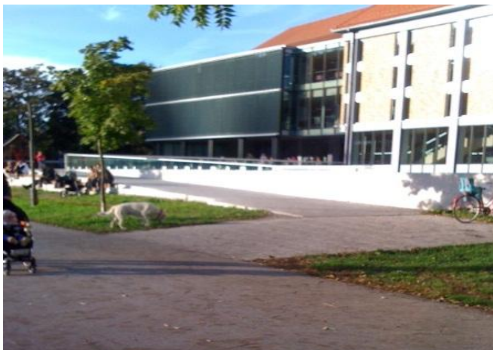
Slika 30: Osrednja knjižnica Celje, kjer je predvideno nadvišanje opornega zidu za zagotavljanje poplavne varnosti (Vir: Bukovski, 2012).
