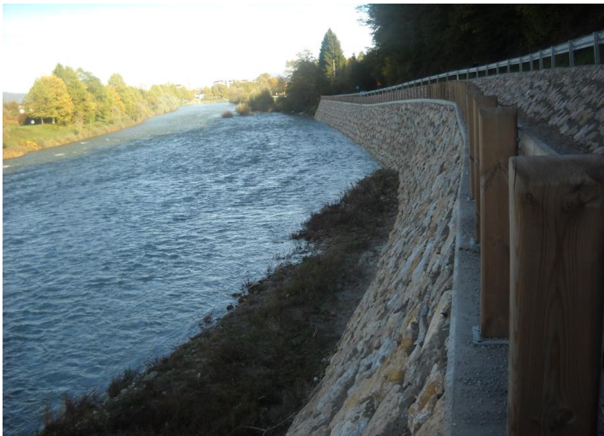
Slika 38: Leta 2010 zgrajen kamniti oporni zid z leseno varnostno ograjo na desni brežini reke Savinje (Vir: Bukovski, 2012).
