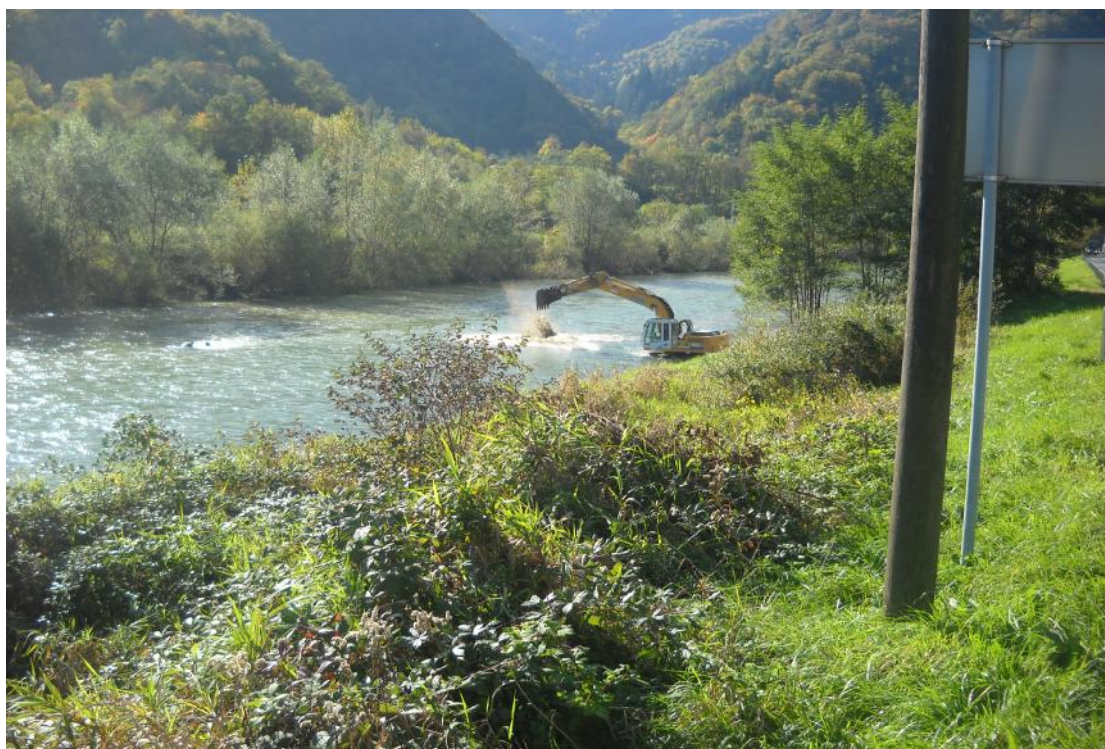
Slika 26: Gradnja protipoplavne zaš ite na obmo ju Polul (Vir: Bukovski, 2012).
