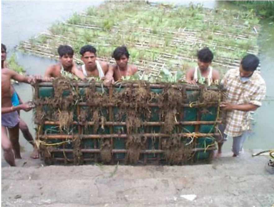
Slika 22: RČO, ki uporabljajo bambus kot glavni material za nosilec, (Vir: Headley in Tanner, 2006)
