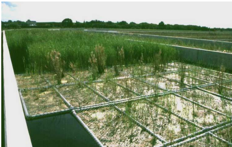
Slika 5: Plavajoči splavi v čistilni napravi na letališču Heathrow (V. Britanija), (Vir: Headley in Tanner 2006)
