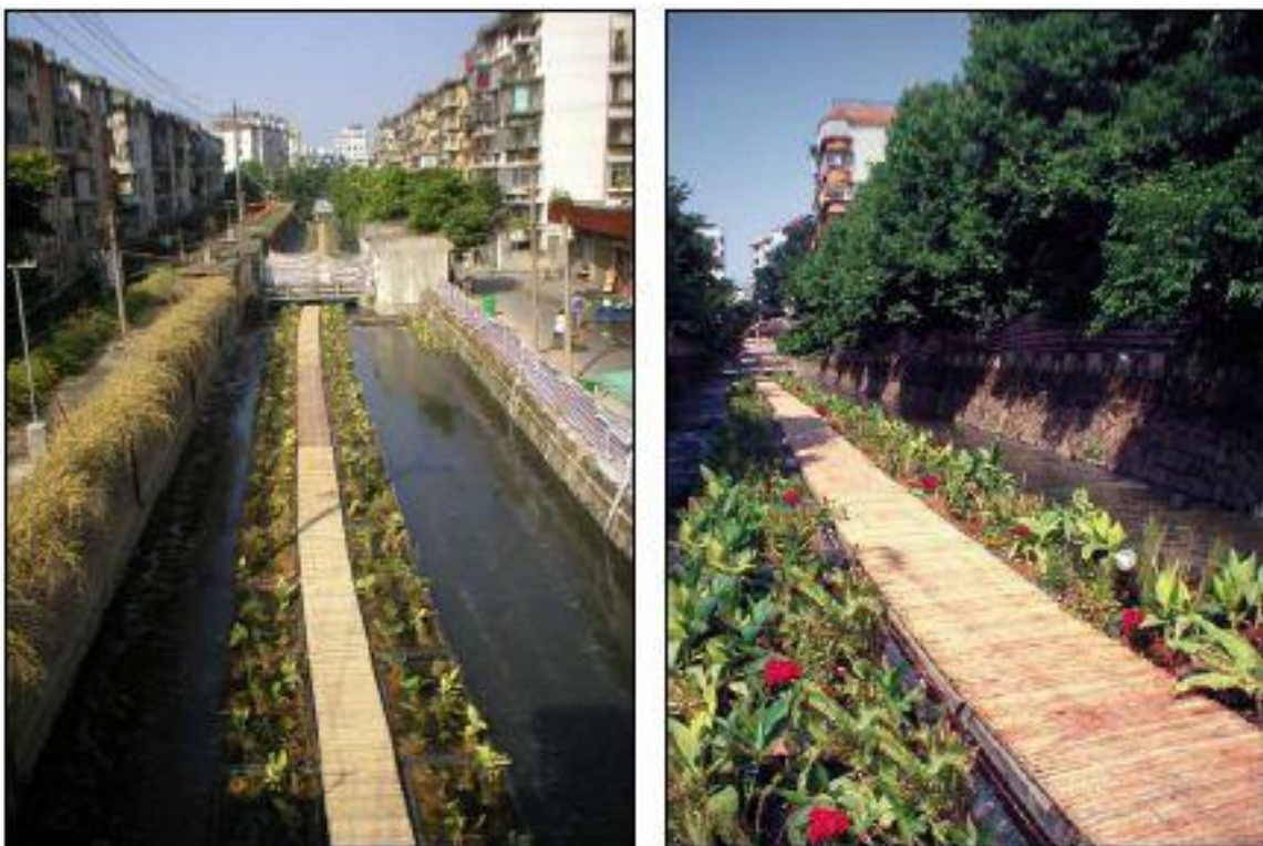
Slika 7: Uporaba RČO pri linearnem čiščenju rečne struge (Kitajska), (Vir: Headley in Tanner, 2006)
